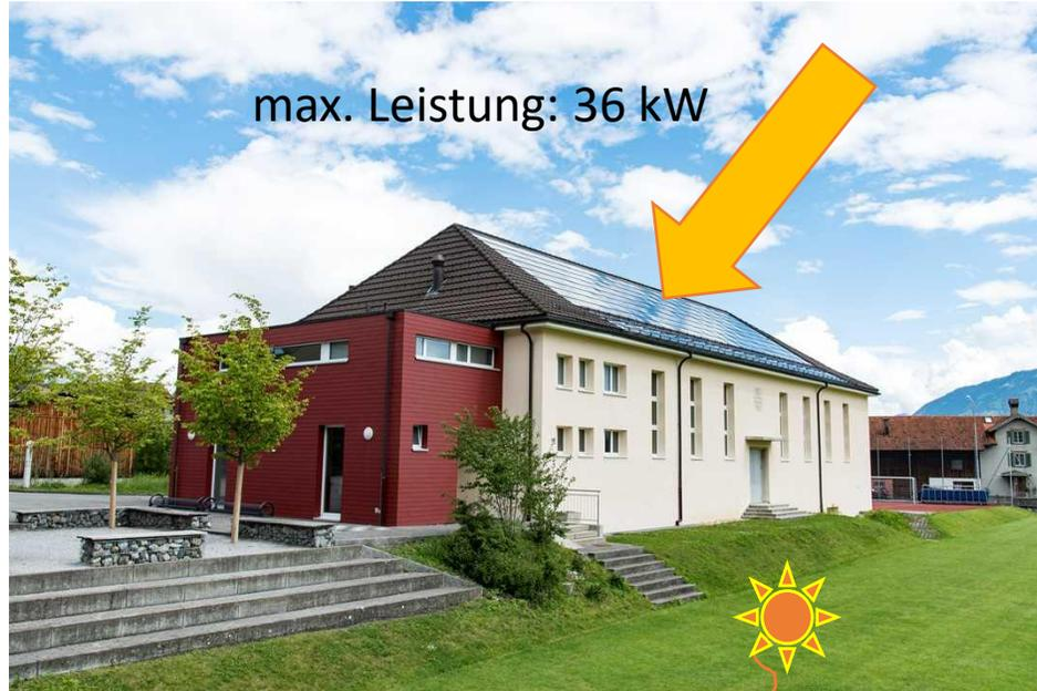
Photovoltaikzellen aus Silizium können heute 14 % bis 20 % der auftreffenden Sonnenenergie in elektrische Energie umwandeln.
