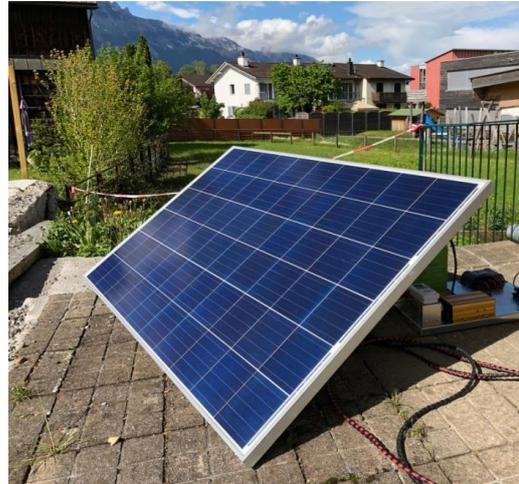
Am Rahmen des Photovoltaikmoduls ist ein Blech mit Schraube angebracht, um die Ausrichtung nach dem Sonnenstand zu erleichtern.
